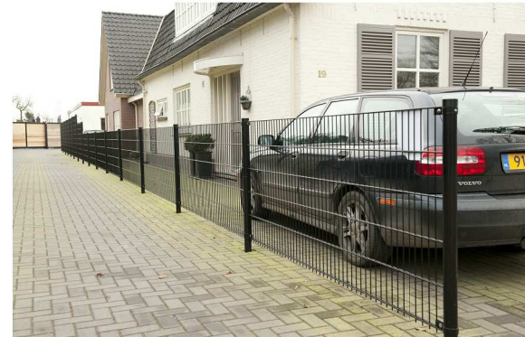
van de Wardt hekwerk 1200mm hoog om het terrein
